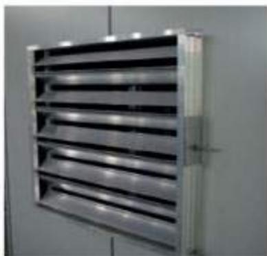
Damper de control o mezcla de aire.
