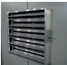
Damper de control o mezcla de aire.
